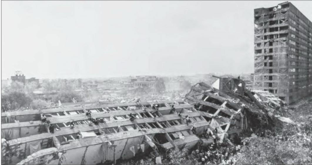
▲ Dos de las tres secciones del edificio Nuevo León, de 15 pisos cada una, quedaron completamente destruidas, mientras la tercera se mantuvo en pie, pero con graves daños, por lo que posteriormente tuvo que ser demolida. La imagen, en la que
